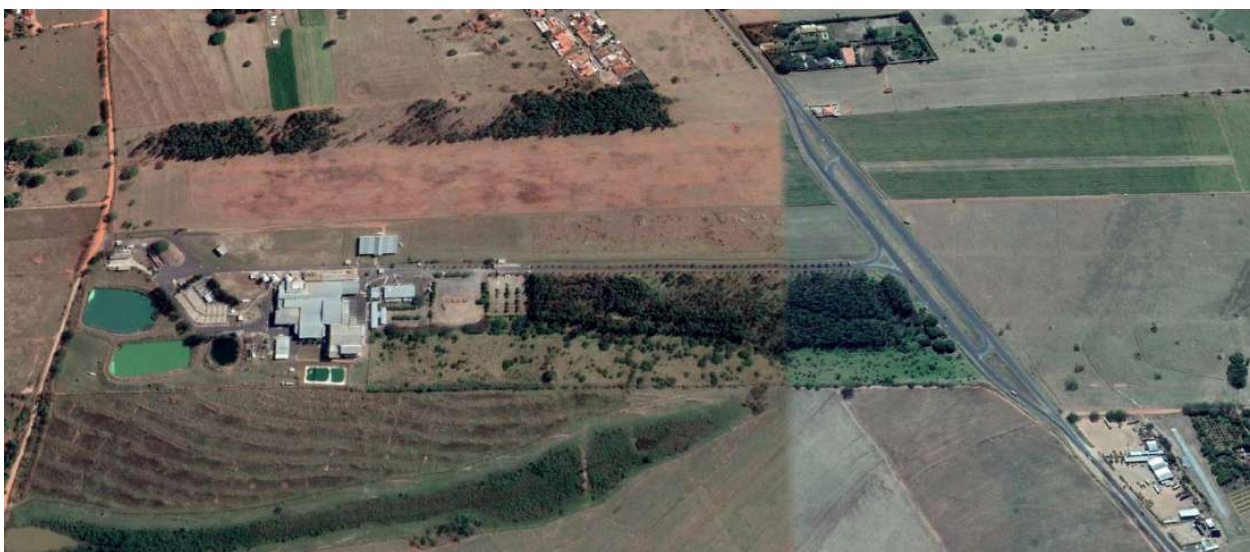
Figura 2-LOCALIZAÇÃO DE INSTALAÇÃO CALDEIRA AR4N MARFRIG PROMISSÃO BLOCO B
