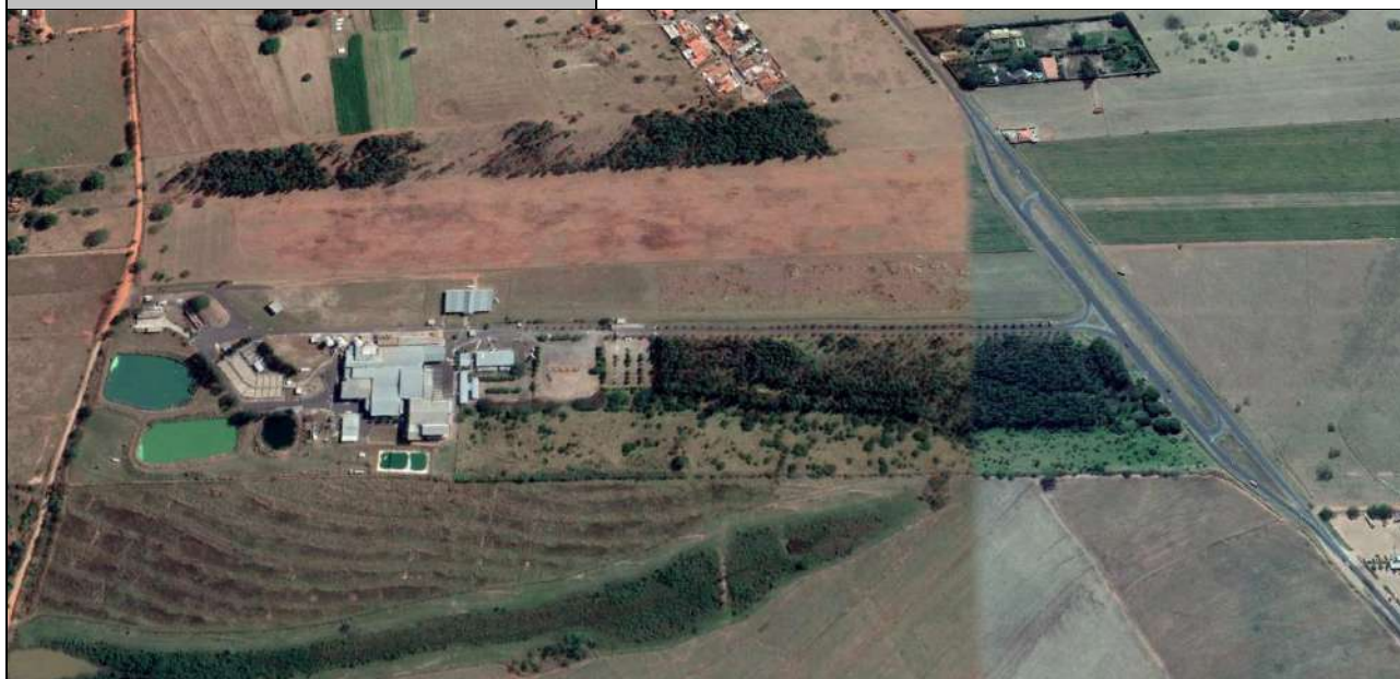
Figura 2-LOCALIZAÇÃO DE INSTALAÇÃO CALDEIRA AR4N MARFRIG PROMISSÃO BLOCO B
