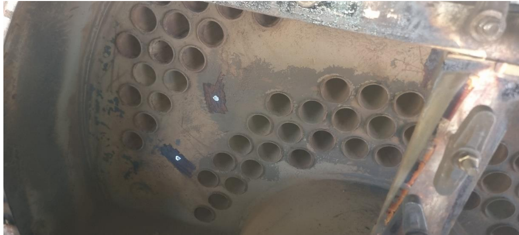
Figura 8-ANTE FORNALHA DIANTEIRA (ACESSO AO ESPELHO)
