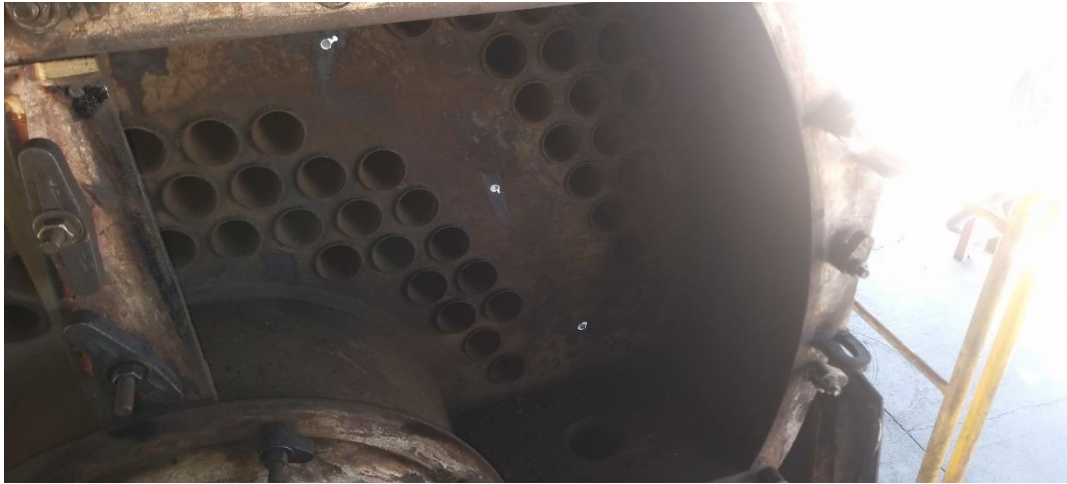
Figura 7-CAMARA DE REVERSAO DIANTEIRA (ACESSO AO ESPELHO)
