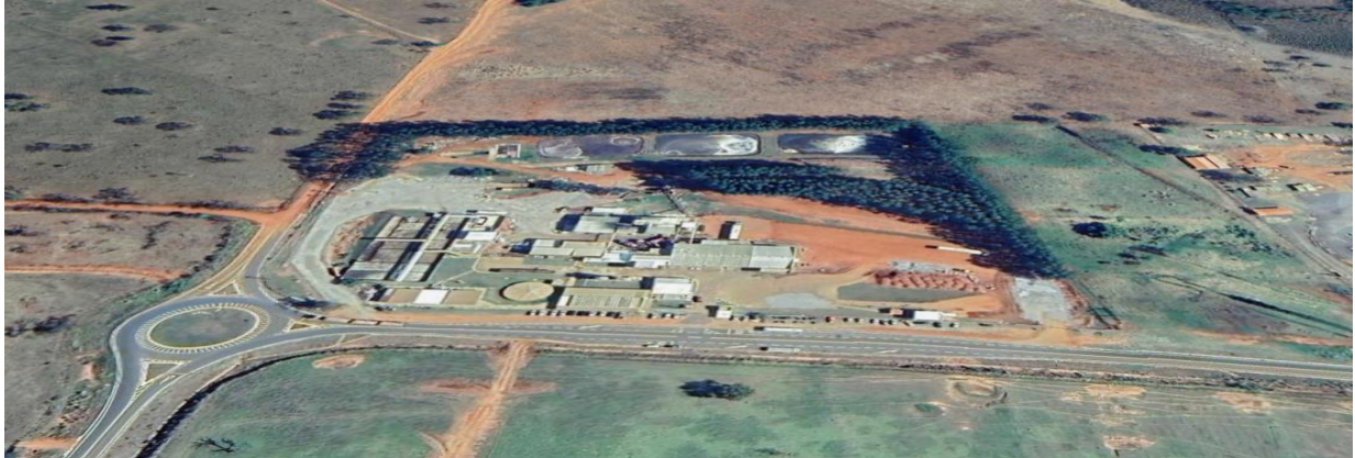
Figura 2-LOCALIZAÇÃO DE INSTALAÇÃO CALDEIRA ATA/ALBORG
