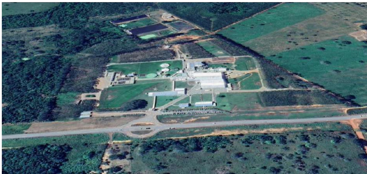
Figura 2-LOCALIZAÇÃO DE INSTALAÇÃO CALDEIRA WS EVO 10
