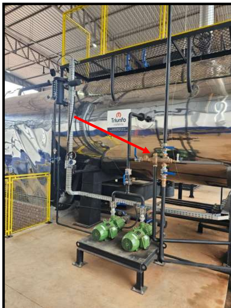
Seta vermelha indica posição da injetora.
