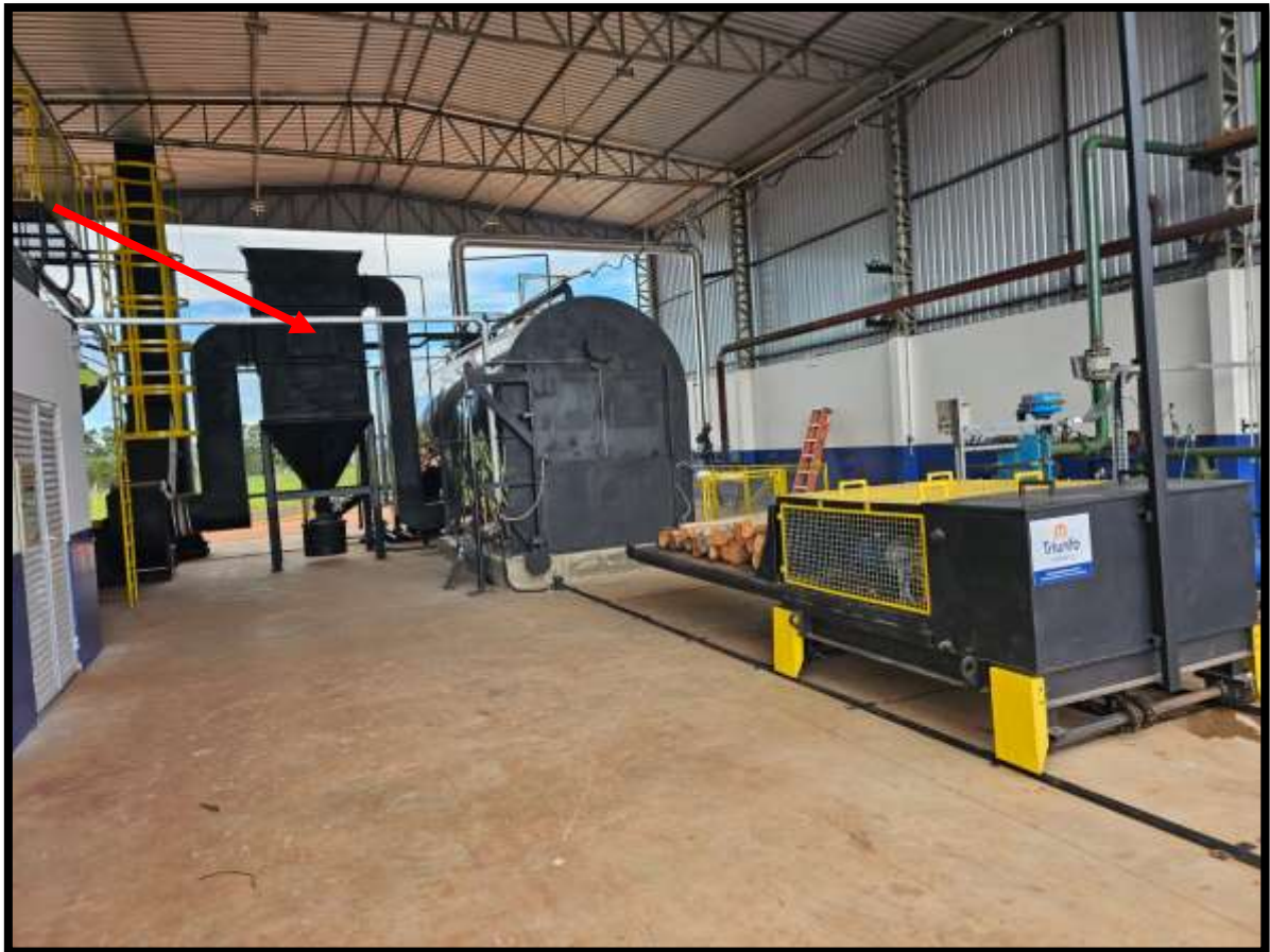
Seta vermelha indica posição do multiciclone.
